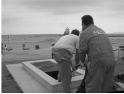
FIGURE 14. Tirage du câble à l'intérieur de la chambre de plage. Le câblage est visible en fond d'image au large et le câble est suspendu sous les bouées rouges.
